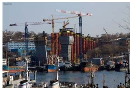
APEC開催に向けての建設工事
